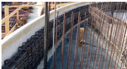
שלב ב' - הרכבה וקשירת ברזל
