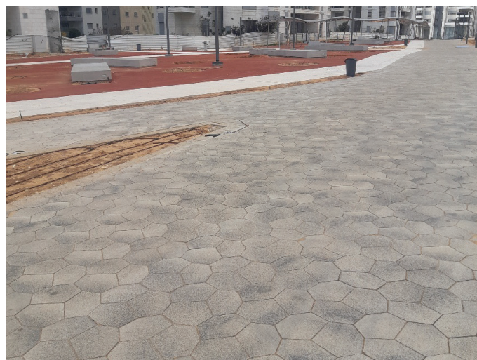
אבן פוליגונלית בגימור אומבריאנו, מגדלים בשדרה חולון קסם אדריכלי נוף
