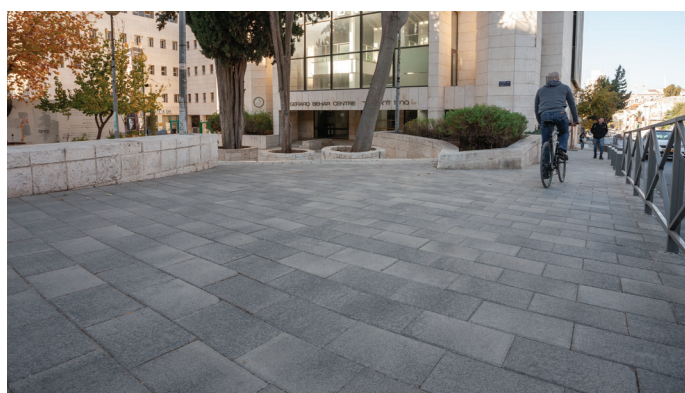
ריצוף אבן טוסקנה בגימור אומבריאנו, רחוב בצלאל, שיקום רחובות ע"פ פרטי מדריך לתכנון רחובות בירושלים בעריכת רחל וינר אדריכלית נוף בע"מ
