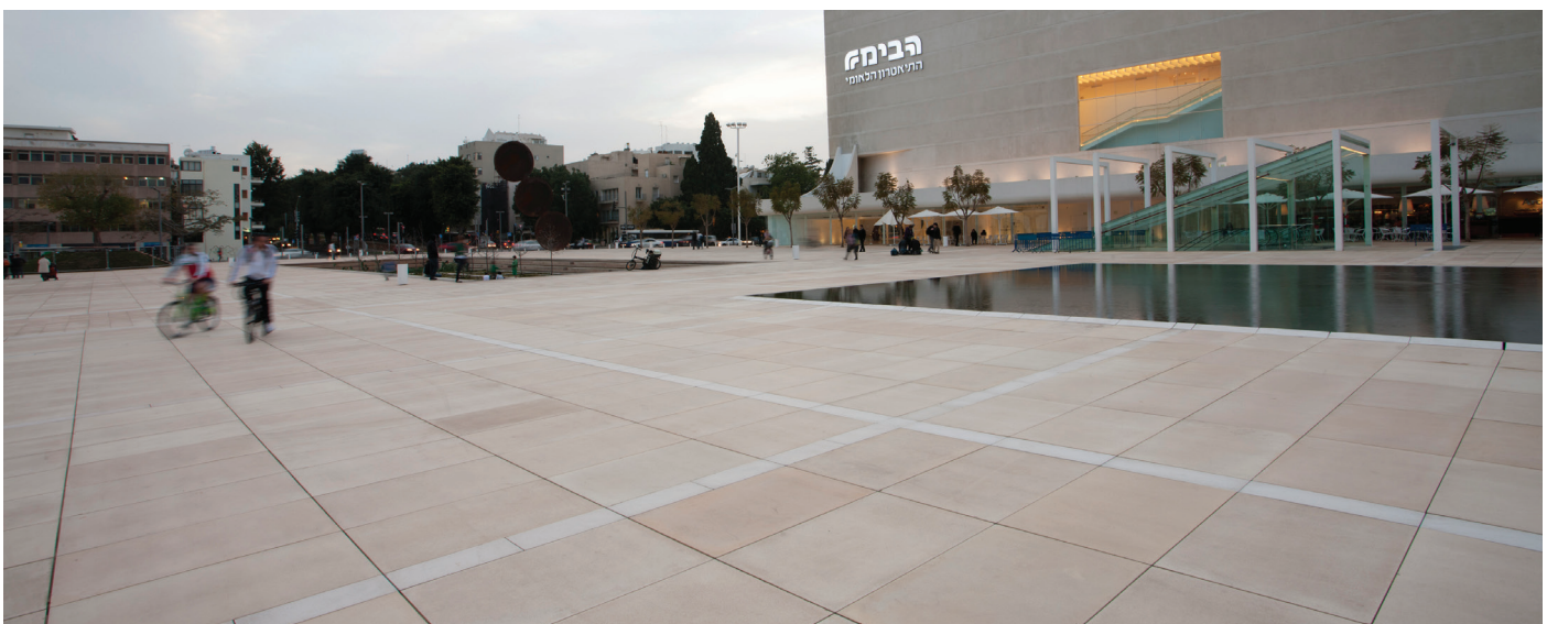
ריצוף באריחי בטון אדריכלי, כיכר הבימה ת"א, ת.מ.א. אדריכלים, פסל דני קרוון.
