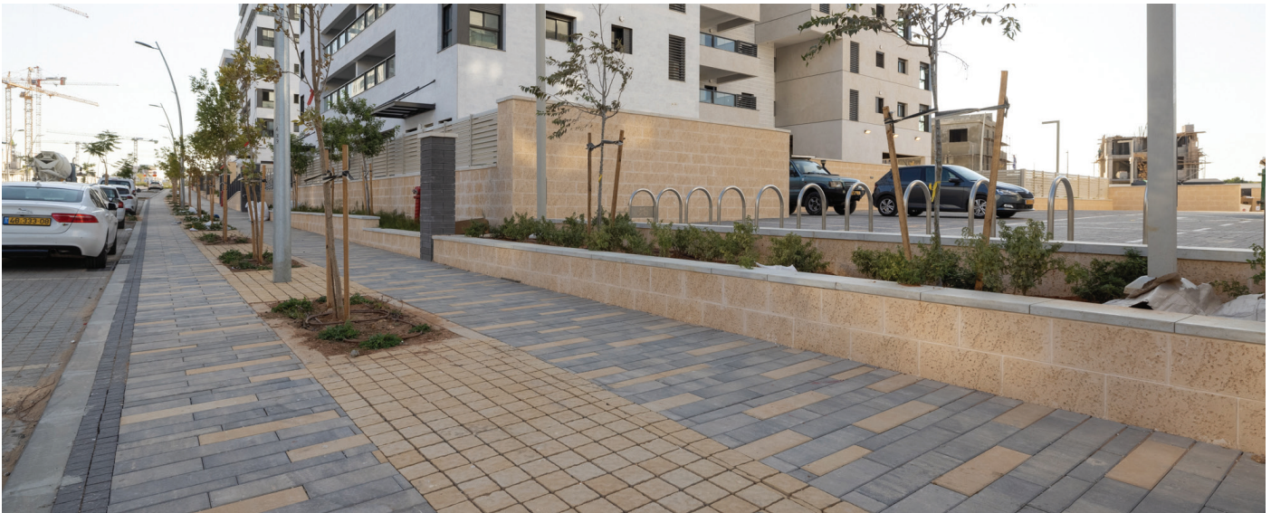
ריצוף אבן הרובע, אקרסטון טבעון מנקז, חיפוי אופק המצוק, שכונת אור ים אור עקיבא, טוך סרגוסי אדריכלות נוף.
